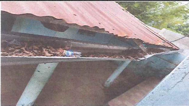
CANAL CON AGUA PLUVIAL EN MAL ESTADO, NECESITA REPARACIÓN
