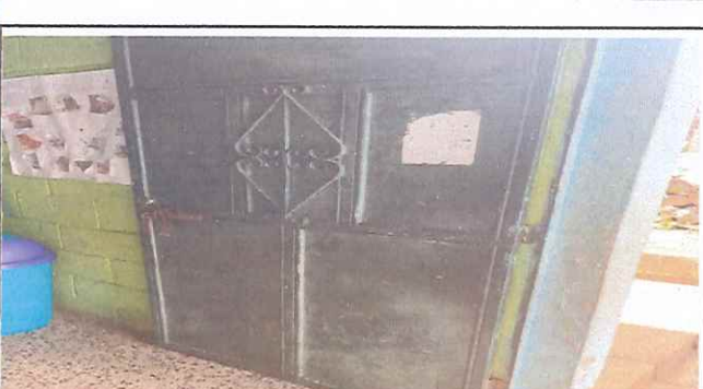
PUERTAS DETERIORADAS, NECESITAN MANTENIMIENTO
