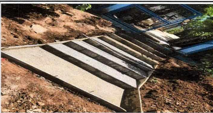
Foto 5: Remodelando el área de ingreso al establecimiento.
