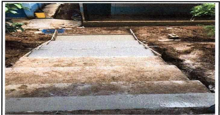
Foto 4: área de ingreso donde se están contruyendo gradas.
