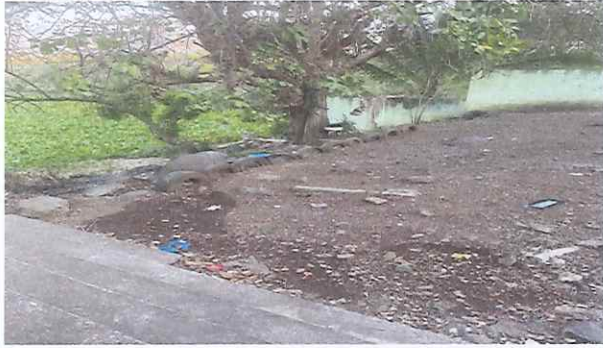
Foto 1: Se construirá un muro de protección para los niños ya que la escuela no cuenta con proyección perimetral en este sector de la misma.
