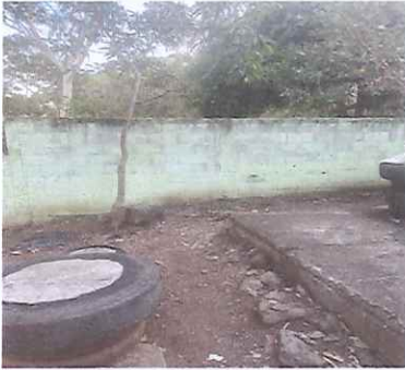
Foto 3: Se voto y se construirá un modulo de baños ya que los que existían eran letritas y estaban obsoletas y antihigiénicas para el esto de la población estudiantil.
