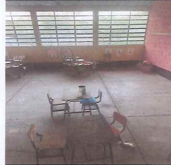
Foto 4: Se colocara piso cerámico en 4 aulas para prestas mejor servicio a los estudiantes ya que son niños y pueden lastimarse con lo rustico de la torta de concreto.
