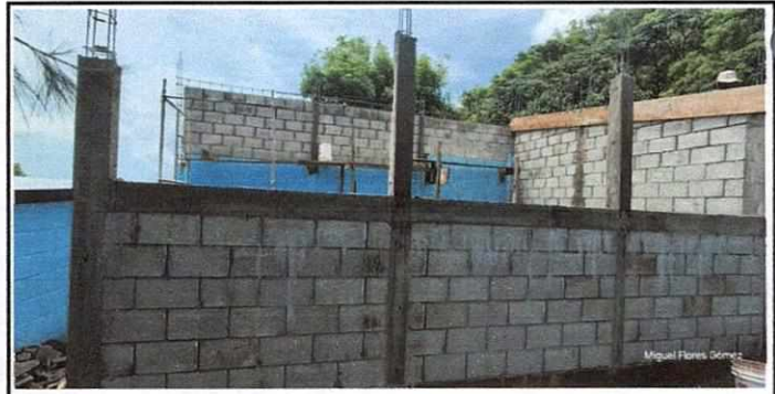
Foto 6: Levantado de paredes del aula
