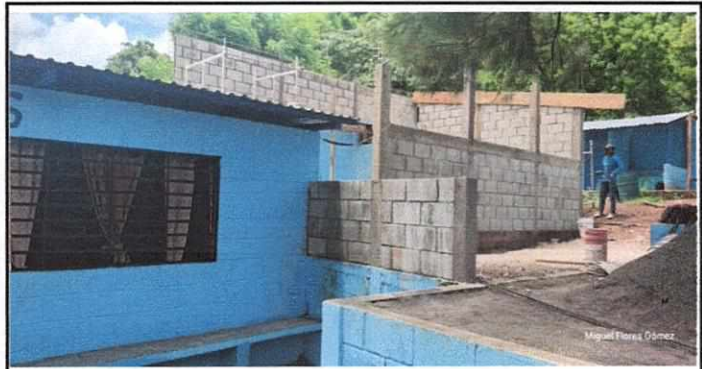
Foto 4: Levantado de paredes del aula
