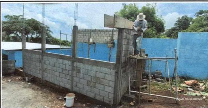
Foto 5: Levantado de paredes del aula
