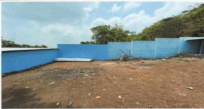
Foto 1: Area donde se ampliará el aula
