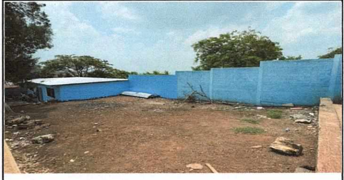
Foto 4: Area donde se ampliará el aula
