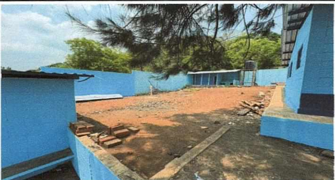
Foto 3: Area donde se ampliará el aula
