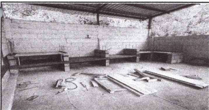
Foto 5: Proceso de remodelación de cocina.
