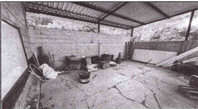
Foto 3: Área donde se aplicará el contrapiso.
