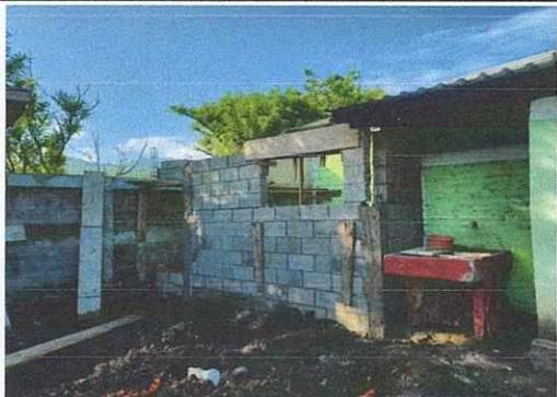
Foto 1: Continuación de levantado de muro, sin techo y sin repello, se cubrira con lámina troquelada y se instalara puerta y balcon
