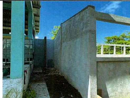
Foto 8: Repello en el exterior del modulo de aula, y trabajos en el modulo de sanitarios.
