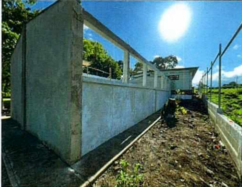
Foto 7: Repello en el exterior del modulo de aula, y fundición de banquetta.
