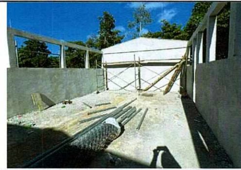
Foto 6: Repello en el interior del modulo de aula.
