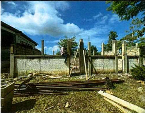
Foto 3: Armado y fundición de columnas secundarias 0.15x0.15 m.
