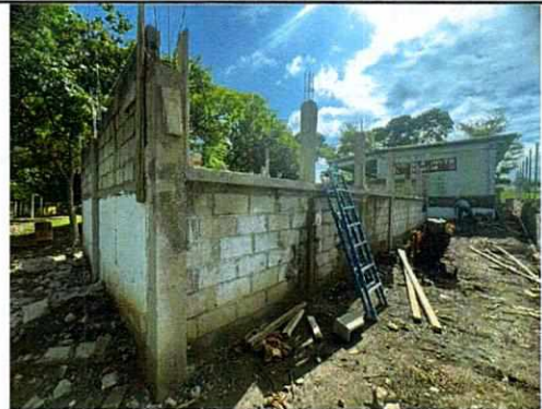
Foto 4: Levantado de block en mojinetes.
