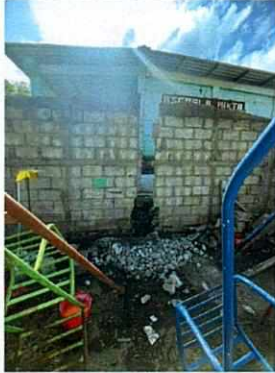
Foto 1: Reforzando el modulo de aula con columnas principales de 0.15x0.20m.
