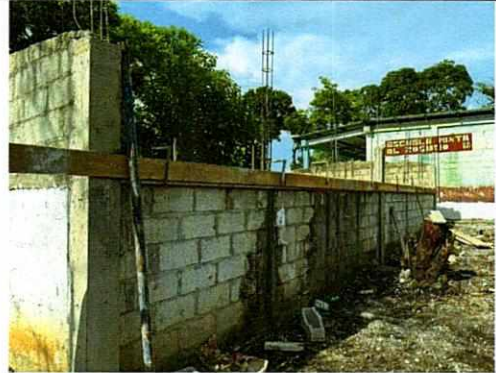
Foto 2: Armado y fundición de solera sillar, 0.15x0.10 m.
