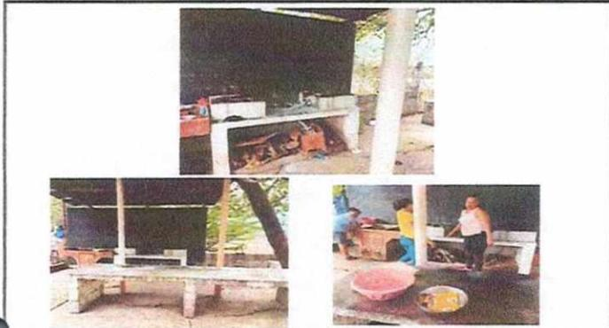
Foto1: Cocina se hará un remozamiento de mesa de concreto, se hará el poyetón con plancha de cocina + chimenea, se colocara azulejo en estufa y paredes, y el remozamiento de la puerta, instalación eléctrica completa.
