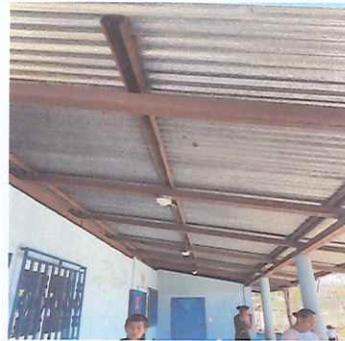
**Foto 2:** Se restaurara toda la estructura metálica con pintura anticorrosiva.
