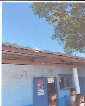
**Foto 3:** Se cambiara la lamina acanalada por lamina troquelada calibre 26 y que la misma se encuentra en mal estado.
