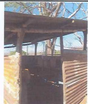
**Foto 4:** Se reconstruirá la bodega de galera con la lamina y costanera de metal galvanizada.
