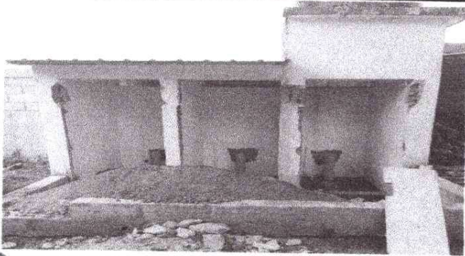
Foto 1: Remodelación de baños en proceso.
