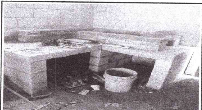
Foto 4: Construcción de plancha y polleton para cocinar en proceso.
