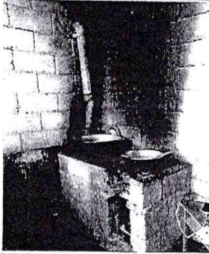
Foto 1: area de cocina a mejorar
