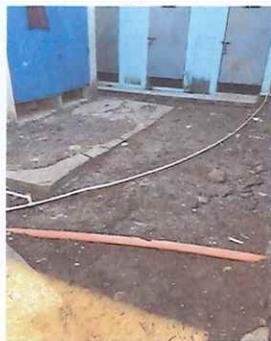
Foto 3: Se cambiara la pila ya que tiene muchas fugas y cambia todo el sistema de agua potable por nuevo, también se fundirá plancha de concreto para que los niños no tengas contacto con el lodo en época de
