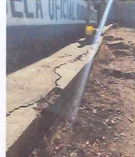
Foto 2: Se construirá nuevamente la acera colocando block pineado de refuerzo.
