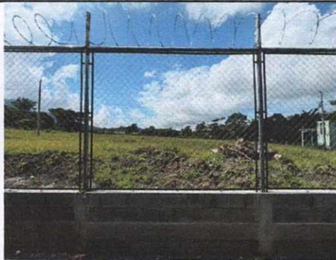
Foto 3: Muro de block y Malla finalizado: cimentación, levantado de block, fundición de columnas y soleras, tubos galvanizados de 2", malla ciclón de 2 m. tensada con plana 1" x 3/16", razor ribbon galvanizado.
