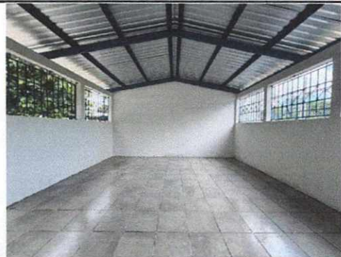
Foto 4: Instalación de 70.00 m2 de piso cerámico en formato de 0.42x0.42 m., ciza 4 mm. en el modulo 3 de aulas.
