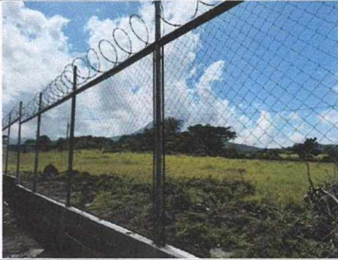
Foto 1: Muro de block y Malla finalizado: cimentación, levantado de block, fundición de columnas y soleras, tubos galvanizados de 2", malla ciclón de 2 m. tensada con plana 1" x 3/16", razor ribbon galvanizado.
