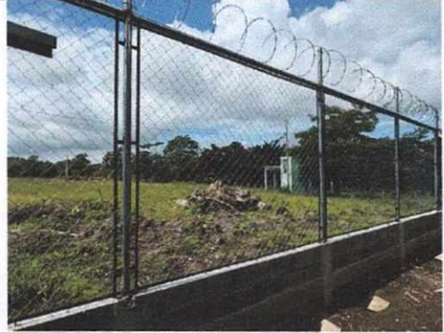
Foto 2: Muro de block y Malla finalizado: cimentación, levantado de block, fundición de columnas y soleras, tubos galvanizados de 2", malla ciclón de 2 m. tensada con plana 1" x 3/16", razor ribbon galvanizado.
