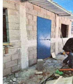
Foto 4: Instalacion de puerta
