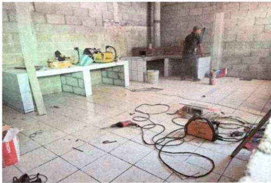
Foto 3: Instalacion de piso
