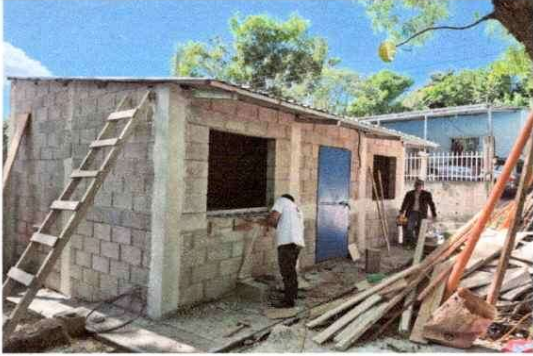
Foto1: area de cocina a mejorar
