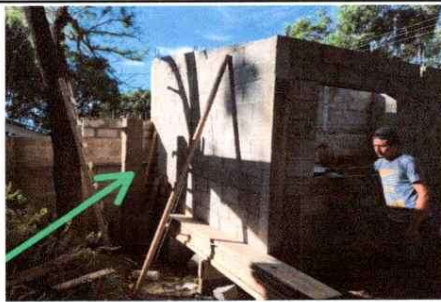
Foto 5: Ampliación de espacio de cocina
