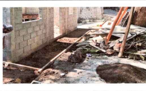
Foto 6: Sustitución de planchas de concreto
