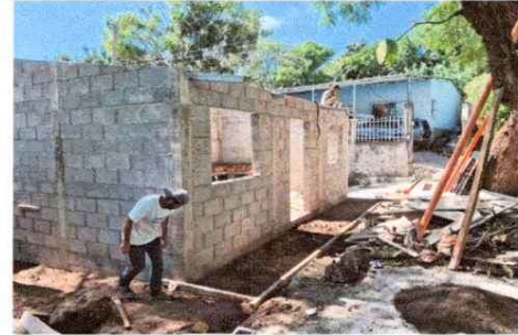
Foto 2: Reparacion de paredes
