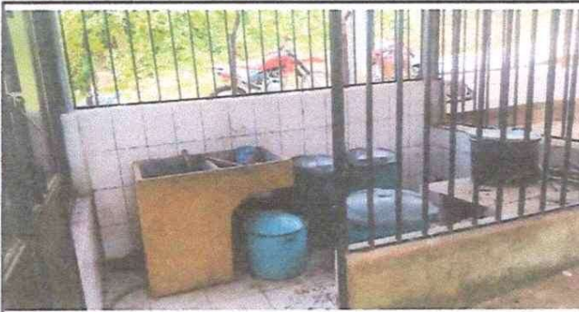
Foto 3: Construcción de pila de concreto
