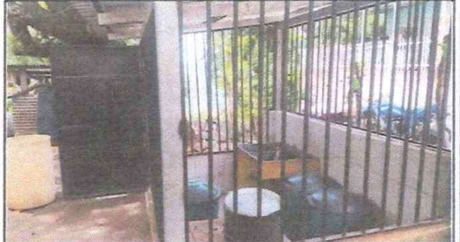
Foto 4: Construcción de estufa tipo rural.
