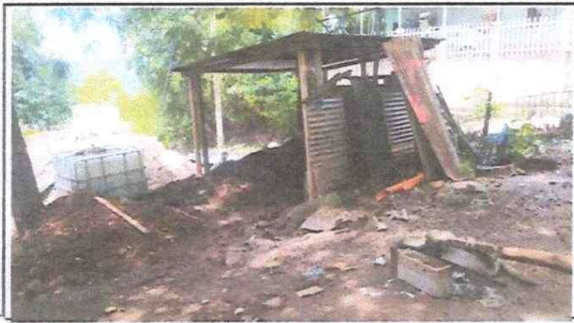
Foto 1: area de cocina a mejorar
