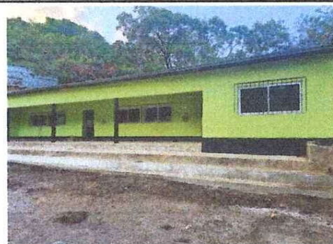
BANQUETA DE MODULO 1 MUY ALTA, NECESITA GRADAS PARA EVITAR ACCIDENTES CON LOS NIÑOS.
