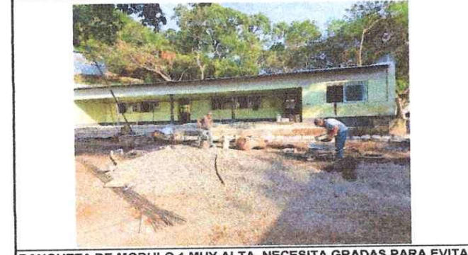
BANQUETA DE MODULO 1 MUY ALTA, NECESITA GRADAS PARA EVITAR ACCIDENTES CON LOS NIÑOS.
