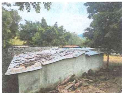
TECHO DE BODEGA EN MAL ESTADO NECESITA SUSTITUCIÓN DE LAMINA
