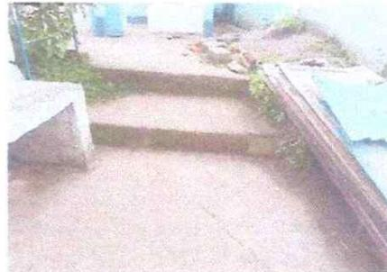
Foto 4: Gradas deterioradas, se hará reparación de las mismas y se realizará una caja receptora de agua pluvial para evitar la saturación de agua en cocina.
