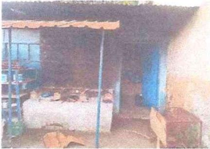
Foto 3: Paredes en mal estado, se hará limpieza y se aplicará repello y cernido en muros existentes.
