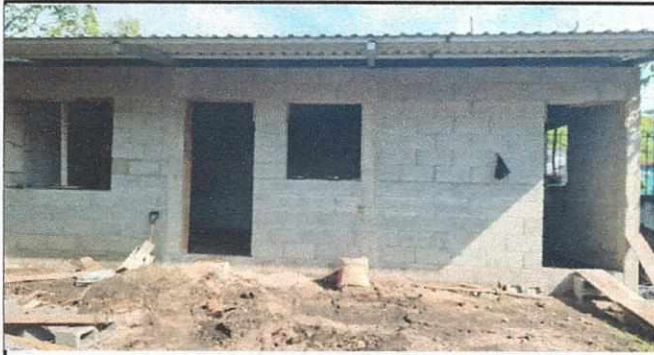
Foto 1: cocina , sin puertas ni balcones para mayor seguridad y se instalara el agua para garantizar el servicio de agua y pila
