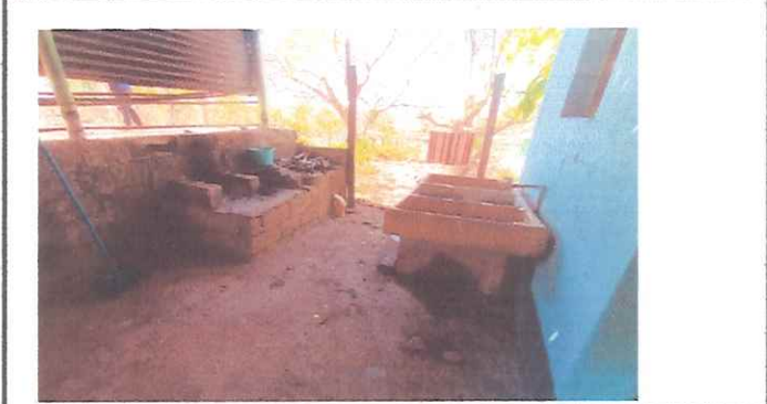
Foto 2: Area de cocina muros no alcanzan el techo, se levantara las columnas para mejorar la altura de la cocina
