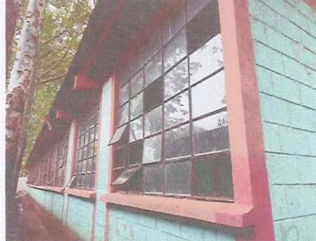
Foto 2: Sustitución vidrios deteriorados y mantenimiento de vidrios en estructura
