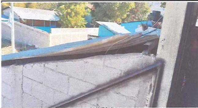
Se necesita mantenimiento de lámina en área de cocina para más durabilidad.
