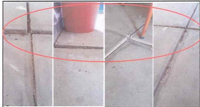
Se necesita cambiar las tortas de cemento de algunas aulas ya que se estan hundiendo, se necesita hacer vaciado de relleno, rellenar y compactar, colocar contrapiso y piso cerámico.
