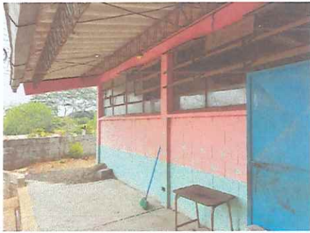
Foto 1: Sustitución de techo y estructura metálica.
