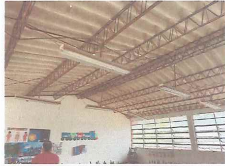
Foto 2: Mejoramiento del sistema eléctrico en interior de aula.
