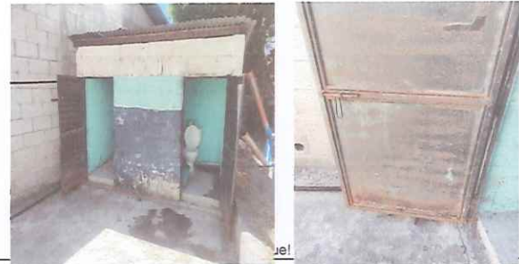
puetas principales en mal estado, necesitan ser reparadas, colocoales chapas y pintarlas
