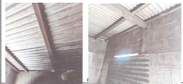
Techo en mal estado de la cocina, se necesita cambio de lamina y su estructura; asi como tambien se necesita una venta con su respectivo balcón.
