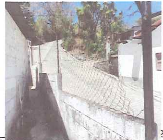
Mejoramiento de muro perimetral.
