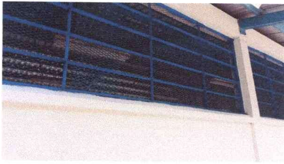
Foto1: MANTENIMIENTO DE VENTANA, SUSTITUCION DE VIDRIO POR LÁMINA DESPLEGADA
