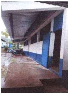
Foto 5: MANTENIMIENTO DE ESTRUCTURA Y SUSTITUCION DE LÁMINA
