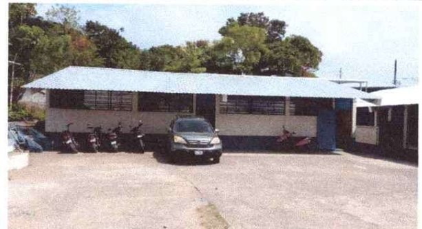
Foto 4: MANTENIMIENTO DE ESTRUCTURA Y SUSTITUCION DE LÁMINA
