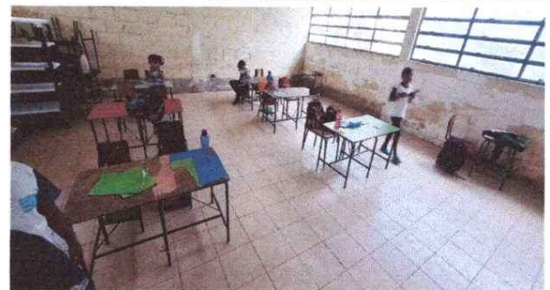
Foto 6: INSTALACION DE PISO CERÁMICO
