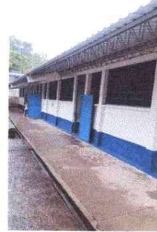
Foto 2: MANTENIMIENTO DE VENTANERIA, SUSTITUCION DE VIDRIO POR LÁMINA DESPLEGADA Y MANTENIMIENTO DE PUERTAS
