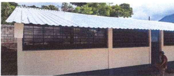
Foto 5: MANTENIMIENTO DE ESTRUCTURA Y SUSTITUCION DE LÁMINA
