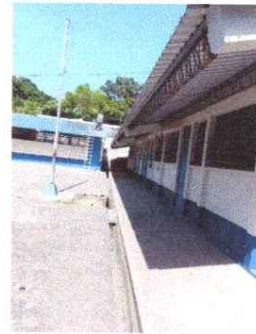
Foto 2: MANTENIMIENTO DE VENTANERIA, SUSTITUCION DE VIDRIO POR LÁMINA DESPLEGADA Y MANTENIMIENTO DE PUERTAS
