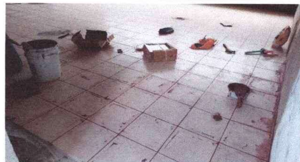
Foto 6: INSTALACION DE PISO CERÁMICO
