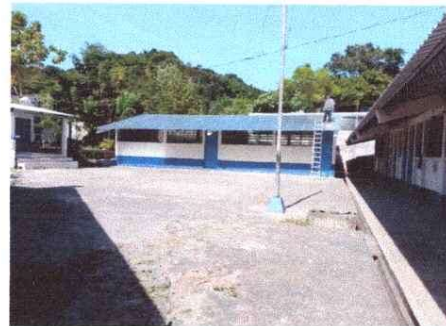
Foto 4: MANTENIMIENTO DE ESTRUCTURA Y SUSTITUCION DE LÁMINA
