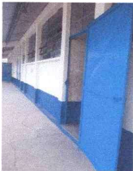
Foto3: MANTENIMIENTO DE VENTANERIA, SUSTITUCION DE VIDRIO POR LÁMINA DESPLEGADA Y MANTENIMIENTO DE PUERTAS
