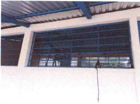
Foto1: MANTENIMIENTO DE VENTANA, SUSTITUCION DE VIDRIO POR LÁMINA DESPLEGADA
