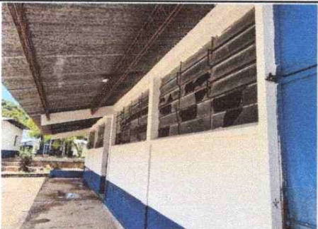
Foto 5: MANTENIMIENTO DE ESTRUCTURA Y SUSTITUCIÓN DE LÁMINA
