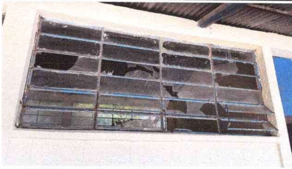
Foto 1: MANTENIMIENTO DE VENTANERIA, SUSTITUCIÓN DE VIDRIO POR LÁMINA DESPLEGADA
