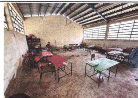
Foto 6: INSTALACIÓN DE PISO CERÁMICO
