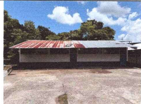
Foto 4: MANTENIMIENTO DE ESTRUCTURA Y SUSTITUCIÓN DE LÁMINA
