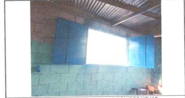
Foto 4: VENTANAS METÁLICAS MEJORADAS CON DOS HOJAS
