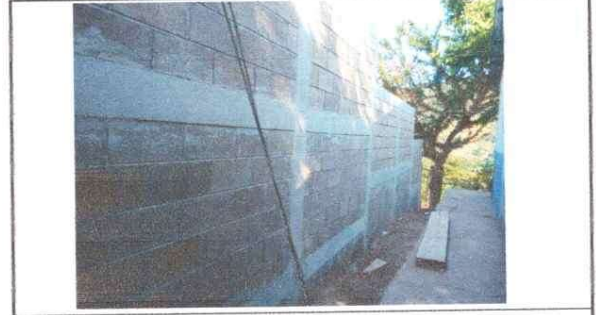
Foto 2: MURO EXISTENTE TERMINADO
