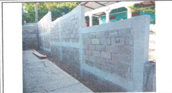
Foto 1: MURO EXISTENTE TERMINADO
