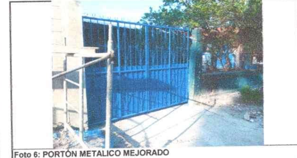
Foto 6: PORTÓN METÁLICO MEJORADO
