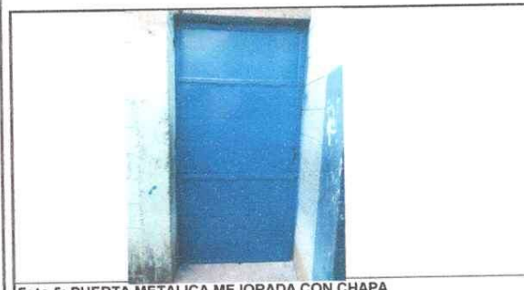
Foto 5: PUERTA METÁLICA MEJORADA CON CHAPA
