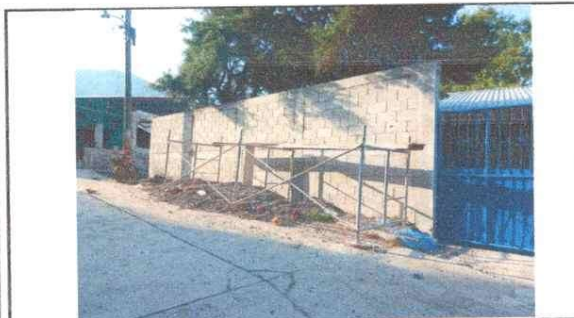
Foto 3: MURO EXISTENTE TERMINADO
