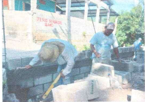
Foto 2: MURO EXISTENTE EN PROCESO
