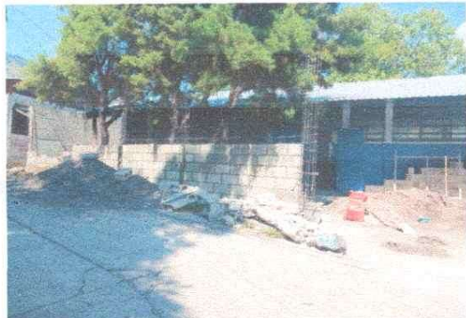
Foto 3: MURO EXISTENTE EN PROCESO
