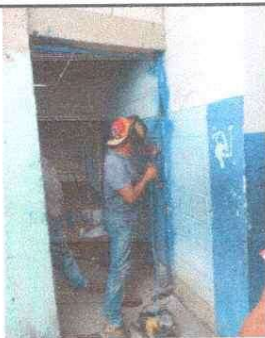
Foto 5: PUERTA METALICA EN PROCESO DE MEJORAMIENTO DE CANDADO A CHAPA
