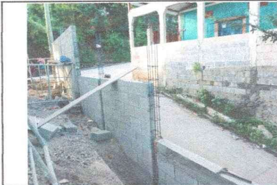
Foto 1: MURO EXISTENTE EN PROCESO
