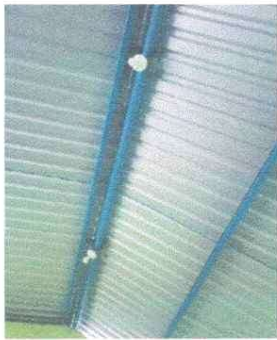
FOTO 3 FINALIZACION DEL MEJORAMIENTO DEL SISTEMA ELECTRICO
