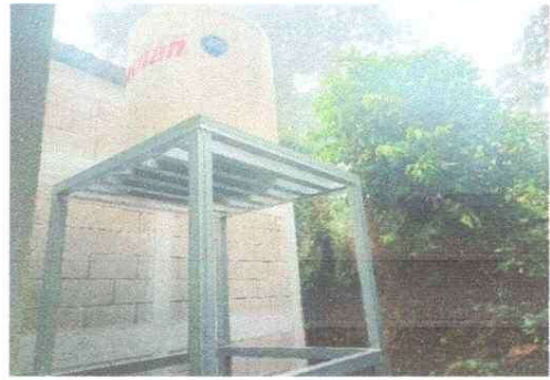
Foto 2: FINALIZACION DE MEJORAMIENTO TINACO EXISTENTE
