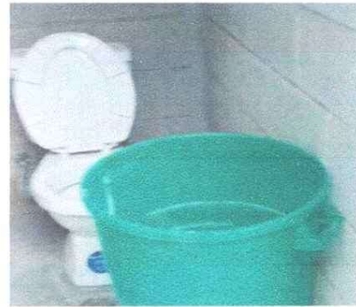
Foto 4: FINALIZACION MEJORAMIENTOS BAÑOS
