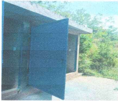
Foto1: PROCESO DE MANTENIMIENTO DE SERVICIOS SANITARIOS
