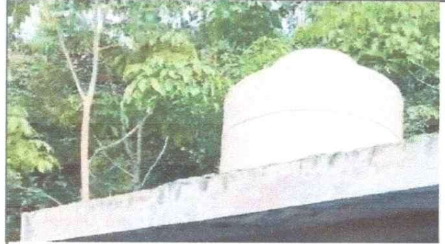
Foto 2: EN PROCESO MEJORAMIENTO TINACO EXISTENTE
