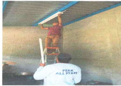
Foto 4: PROCESO DE MEJORAMIENTO DE SISTEMA ELECTRICO GENERAL
