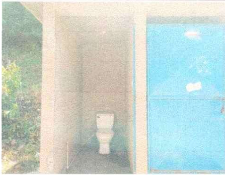
Foto1: MANTENIMIENTO DE SERVICIOS SANITARIOS
