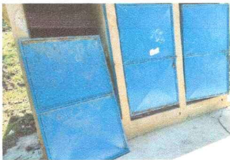
Foto 5: MEJORAMIENTO DE PUERTAS
