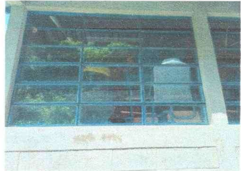
Foto 2: MEJORAMIENTO DE VENTANERIA
