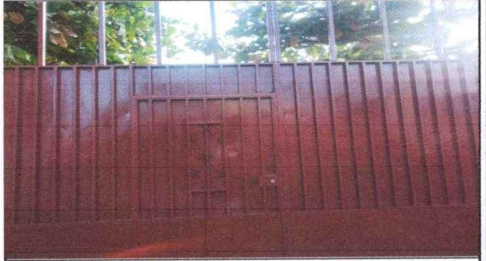
Foto 4: MANTENIMIENTO DE PORTON
