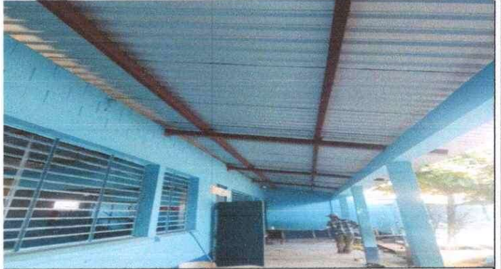
Foto 2: REPARACION DE TECHO
