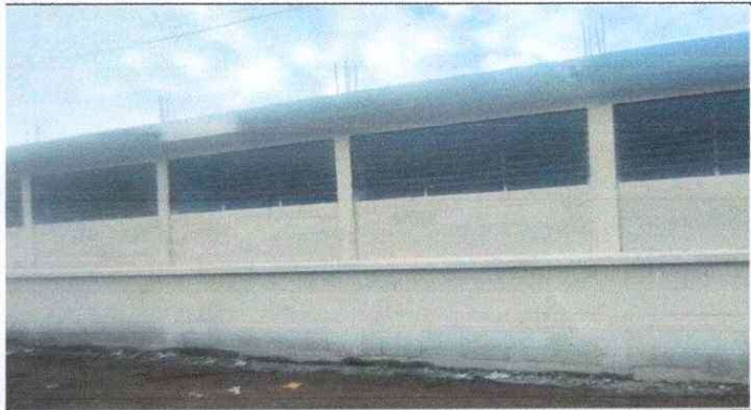
Foto 1: REPARACION DE PARED TRACERA
