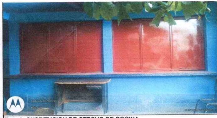
Foto 5: SUSTITUCION DE CTECHO DE COCINA
