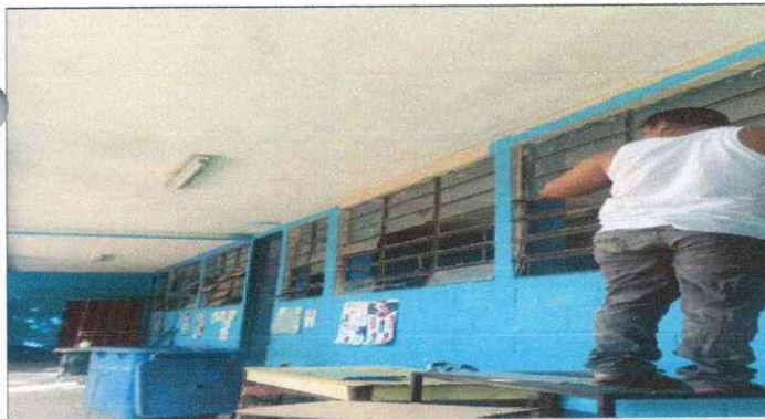
Foto 3: REPARACION DE BALCONES
