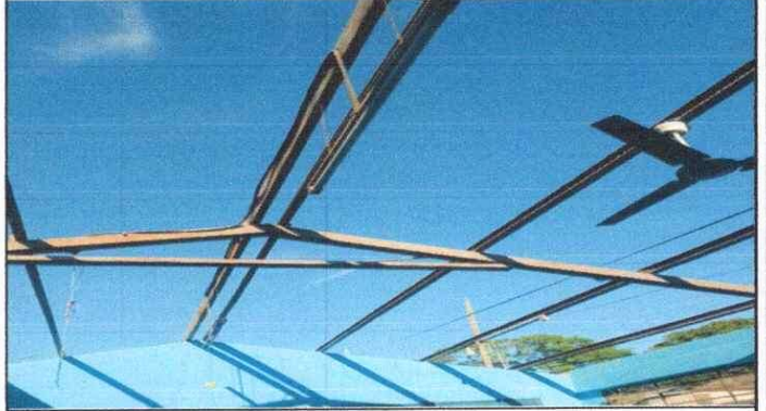
Foto 2: REPARACION DE TECHO
