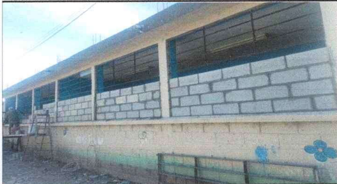
Foto 1: REPARACION PARED TRACERA
