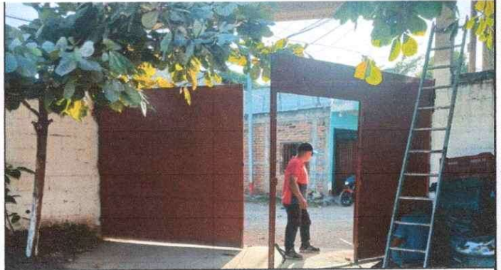
Foto 4: REPARACION DE PORTON
