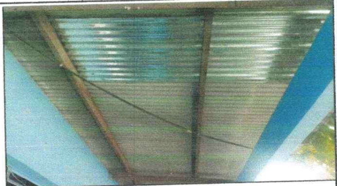
Foto 2: REPARACION DE TECHO
