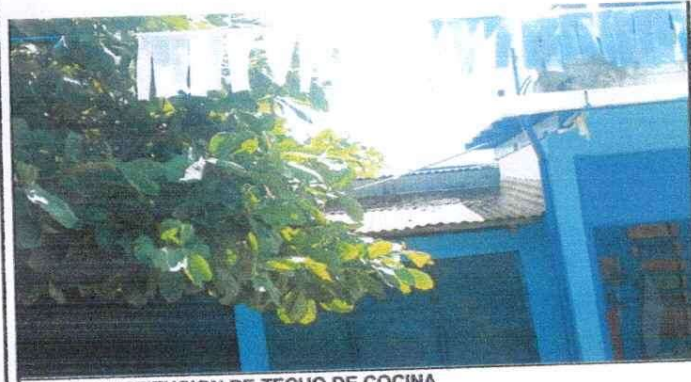
Foto 5: SUSTITUCION DE TECHO DE COCINA
