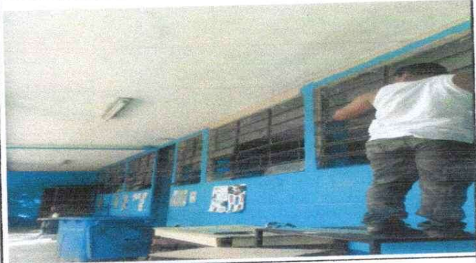
Foto 3: REPARACION DE BALCONES
