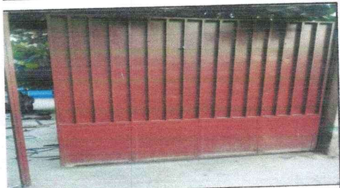
Foto 4: REPARACION DE PORTON
