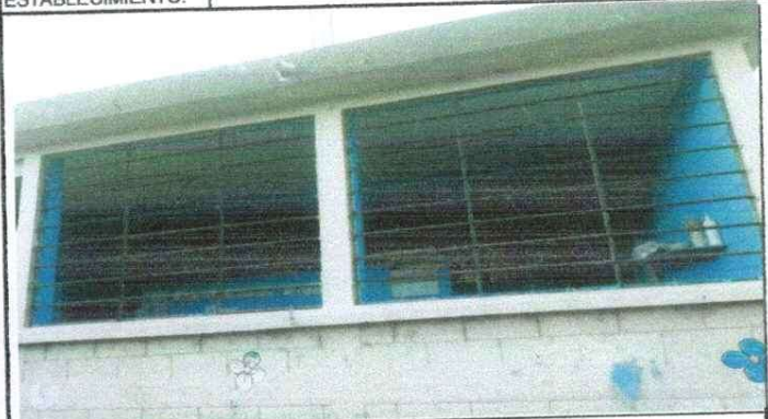
Foto 1: REPARACION DE PARED TRACERA
