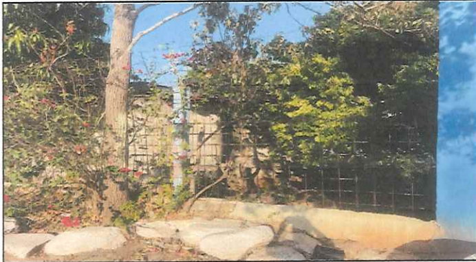
Reparacion del muro perimetral, con block.
