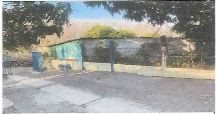
Foto 6: Reoaracion de porton
