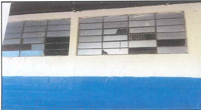
Reparacion de ventanas
