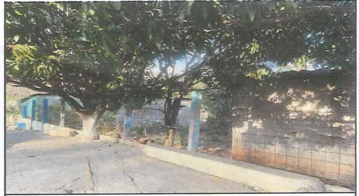
Reparacion del muro perimetral, con block.
