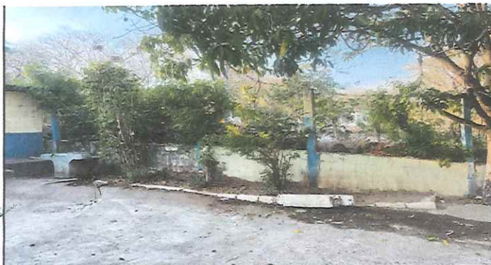
Foto 5: reparacion de cancha
