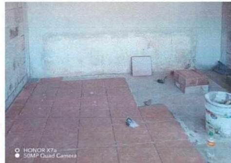
Foto 6: Renglón 6.2 instalación de piso cerámico en cocina
