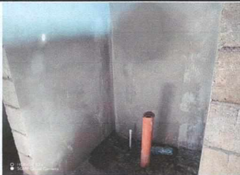
Foto 5: Renglón 10: Servicios sanitarios
