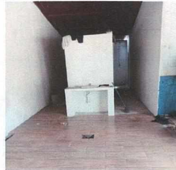
Foto 4: Renglón 6: Piso 4.1 Instalación de piso cerámico
