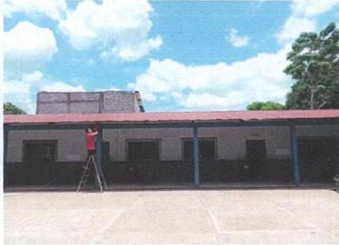
Foto 1: Renglón 1: Cubierta de lámina.
