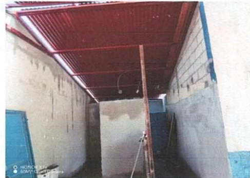
Foto 2: Renglón 2: Estructura de techo.
