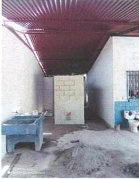
Foto 7: Renglón 14. Reparación de drenaje. 14.1 Reparación de drenaje en baños 14.2 reparación de red de agua potable.
