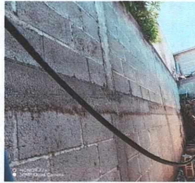
Foto 8: Renglón 17. Reparación de sistema Eléctrico
