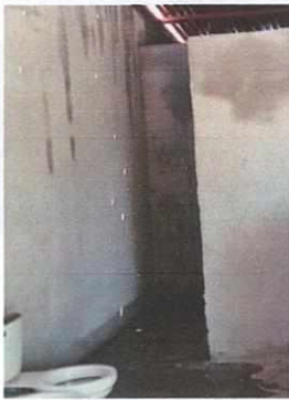
Foto 3: Renglón 4: Puertas (sustición de puertas)
