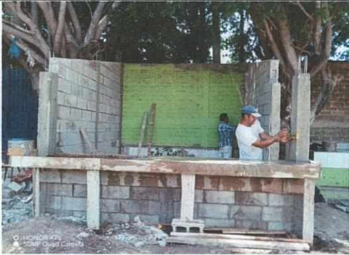
Foto 9: Renglón 20. Reparación de área para cocina
