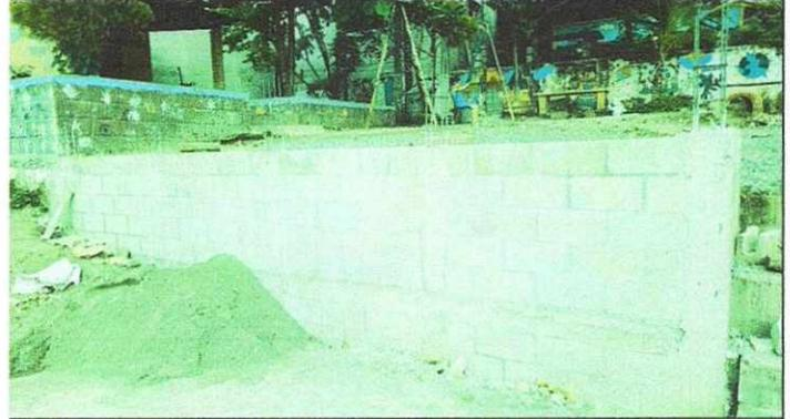
Foto 2: Muro de contención EEORM alde el Manguito
