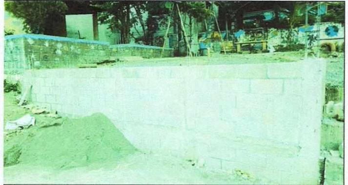
Foto 2: Muro de contención EEORM alde el Managuito
