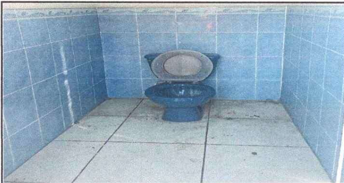
FOTO 3: AREA SANITARIA, SE REMOZÓ Y SE LE COLOCÓ AZULEJO
