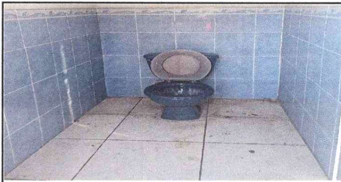
FOTO 3: AREA SANITARIA, SE ESTÁ REMOZANDO Y SE LE ESTÁ COLOCANDO AZULEJO
