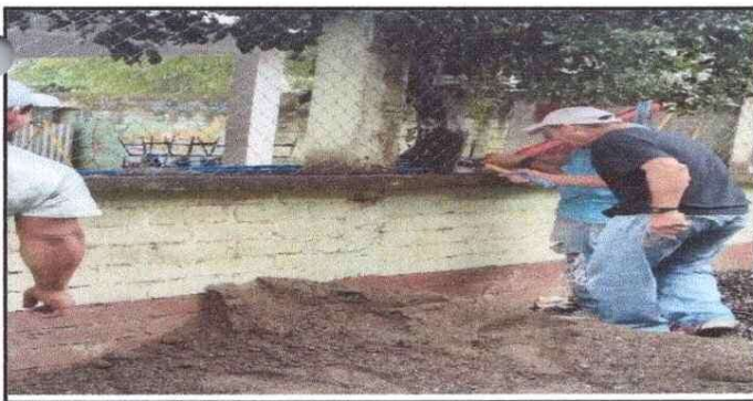
FOTO 5: MURO PERIMETRAL EN MAL ESTADO, SE ESTÁ SUSTITUYENDO LA MALLA GALVANIZADA Y TAMBIEN SE ESTÁ HACIENDO REMOZAMIENTO Y TALLADO DE COLUMNAS
