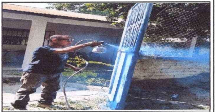
FOTO 6: PUERTAS Y BALCONES DETERIORADOS, SE LES ESTÁ HACIENDO MANTENIMIENTO, APLICACIÓN DE PINTURA A SEGUNDA MANO Y CAMBIO RESPECTIVOS DE CHAPAS
