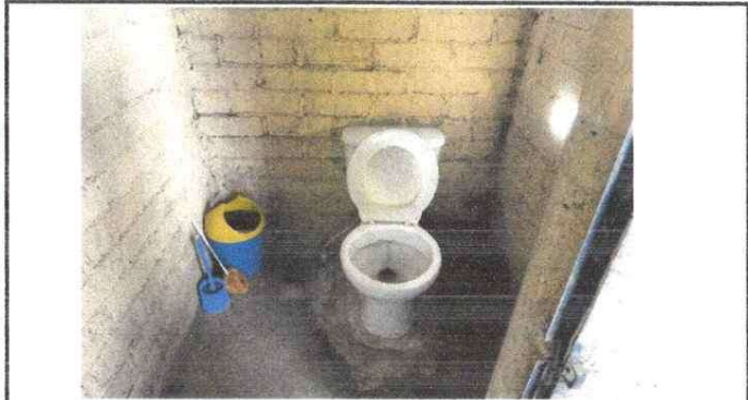
FOTO 3: AREA SANITARIA, SE REMOZARA Y SE LE COLOCARA AZULEJO
