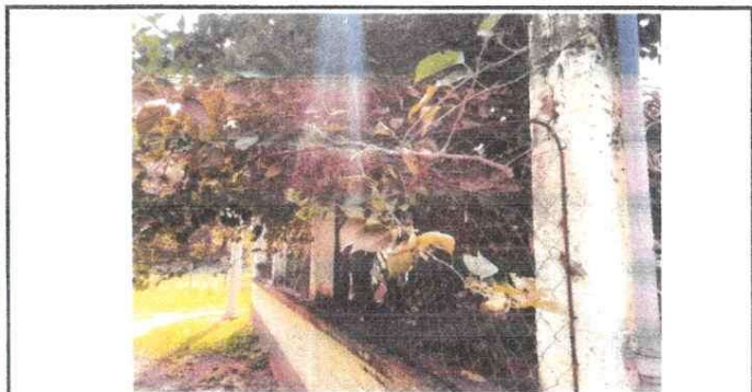
FOTO 5: MURO PERIMETRAL EN MAL ESTADO, SE SUSTITUIRA LA MALLA GALVANIZADA Y TAMBIEN SE HARÁ REMOZAMIENTO Y TALLADO DE COLUMNAS
