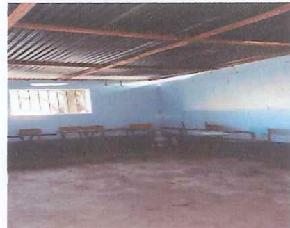
Foto 6: Aula 2, deterioro de techo, piso de cemento, puerta, ventanas y paredes, se realizará cambio de las cosas deterioradas, se instalará piso de granito, se repellarán y pintaran las paredes.
