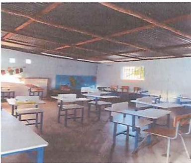
Foto 5: Aula 1 deterioro de techo, piso de cemento, puerta, ventanas y paredes, se realizará cambio de las cosas deterioradas, se instalará piso de granito, se repellarán y pintarán las paredes.
