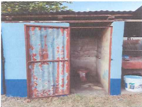
Foto 3: Sanitario 1 con deterioro techo, inodoro y de piso de cemento, paredes sin repello, se cambiará el inodoro por uno de porcelana, cambio techo, instalación de piso y azulejos y repello de paredes.
