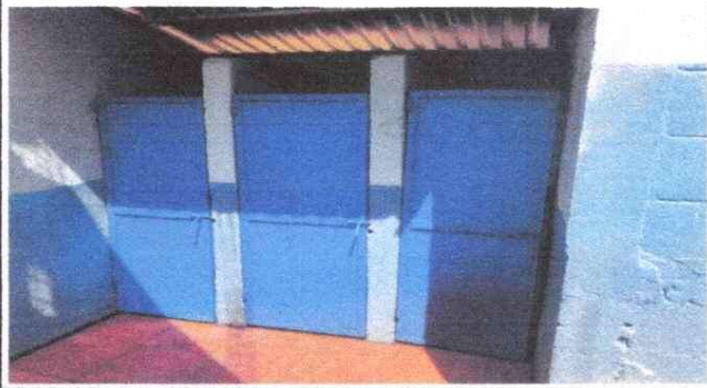
Foto 1: PUERTA: Se cambiarán las puertas de los baños por estar en mal estado
