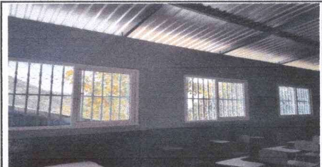
Foto 6: VENTANAS Se cambiaran por ventanas pvc para que la lluvia no entre al aula
