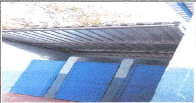
Foto 3: TECHO Cambio de techo modulo baños
