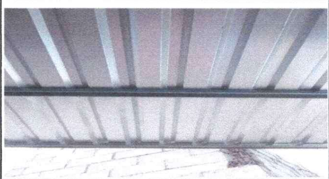
Foto 2: TECHO Se cambio la madera rustica por estructura metalica en los baños
