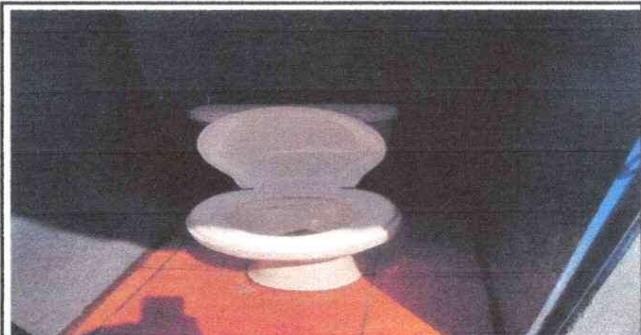
Foto 4: SANITARIOS Se cambiaran los inodoros
