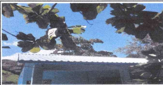
Foto 5: TECHO: cambio de techo en el modulo de aulas
