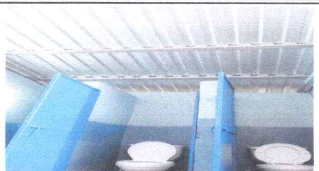
Foto 2: TECHO cambio la madera rustica por estructura metalica en los baños
