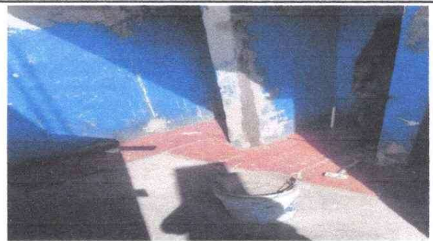
Foto 4: SANITARIOS Se cambiaron los inodoros
