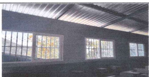
Foto 6: VENTANAS Se cambiaron por ventanas pvc para que la lluvia no entre al aula
