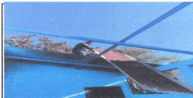
Foto 5: TECHO: cambio de techo en el modulo de aulas.
