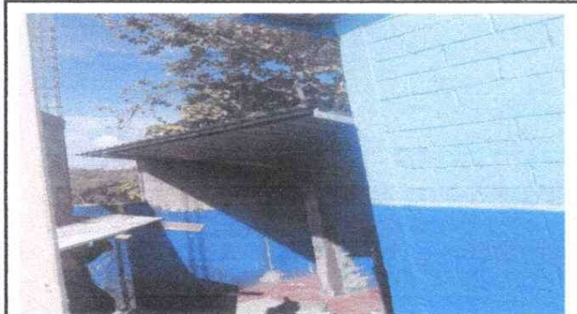
Foto 3: TECHO Cambio de techo modulo baños
